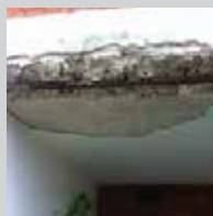
Spalling
